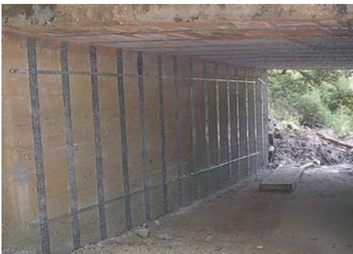
コンクリート橋げたの補強例:
