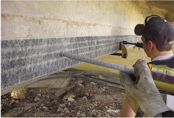
コンクリートガーダー(梁)への補強帯施工作業:
