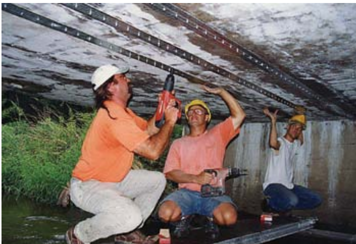
コンクリートスラブの補修作業:
