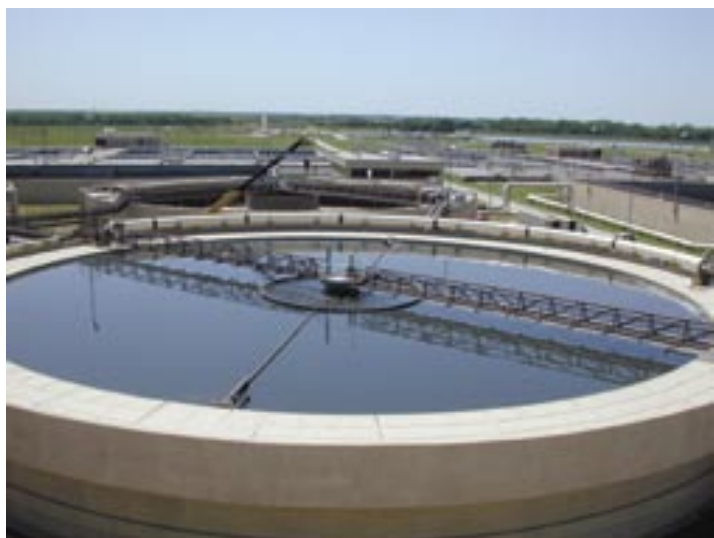
沈殿池廻りのカバーに使用されたコンポゾライト： Trinity River Waste Water Treatment Plant in Dallas, Texas 強度、軽量、耐腐食性が評価され、採用されました。
