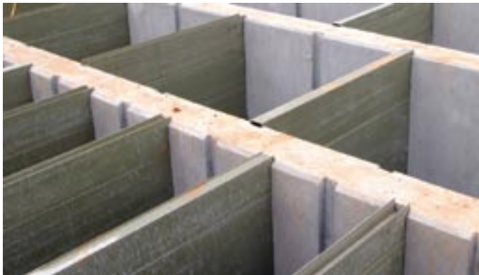
塩素殺菌を行なう水処理設備のバッフル板として、コンポライトパネルを使用しました。 コンポライトパネルの用途は、工夫により多岐に渡ります。
