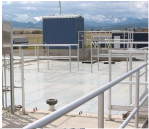
コンポライトとセーフレール（FRP製手摺）の組合わせ： 鉄道脇の歩廊を施工。低コスト、低メンテナンス、耐腐食性。
