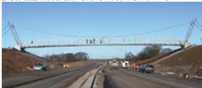
歩行者横断橋に使用されたコンポゾライト： The Wilcott pedestrian bridge in Shropshire, England 歩道橋の全長は約50m、巾約2.1m。パネル、3-Wayコネクタ、 トグルによる構成です。
