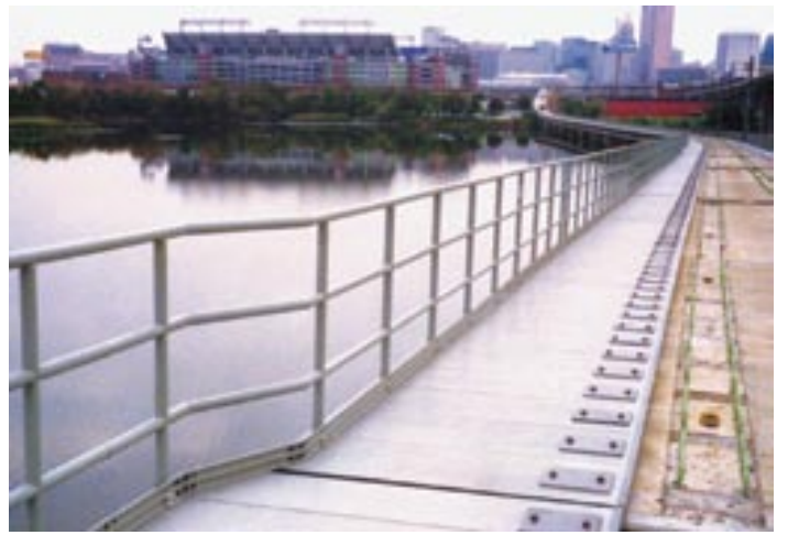
コンポライトとセーフレール（FRP製手摺）の組合わせ： 鉄道脇の歩廊を施工。低コスト、低メンテナンス、耐腐食性。
